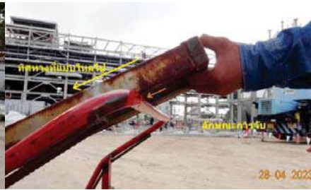
ภาพแสดงการทำท่าทางผิดปกติ การขนส่งแบบเทปูน และการจับชิ้นงานเพื่อบังคับทิศทางรถเข็น
