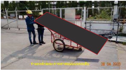
ภาพแสดงการทำท่าทางผิดปกติ การขนส่งแบบเทปูน และการจับชิ้นงานเพื่อบังคับทิศทางรถเข็น
