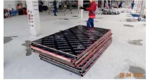
ภาพแสดงแผ่นแบบเทปูนน้ำหนักแผ่นละ 70 kg. ที่ทำการขนเข้าโรงงานโดยใช้รถเข็นขน ครั้งละ 2 แผ่น
